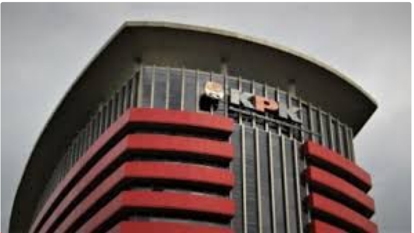
Dok. Gedung KPK
