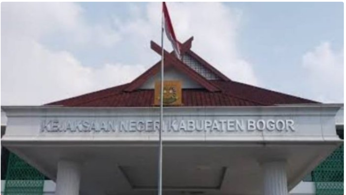
Photo : Gedung Kejari Kabupaten Bogor
